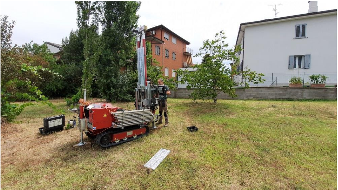
Foto 1: CPT-1 in esecuzione
